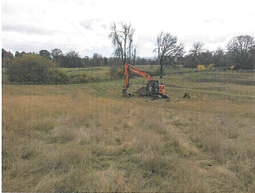
Test Pit TP-6
