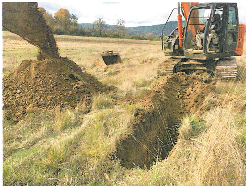
Test Pit TP-6
